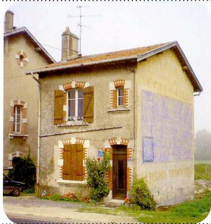
Liseré d'enduit lissé typique de la Reconstruction. Il souligne les ouvrages en briques et met en valeur, par contraste, le grain plus épais du mur enduit.
