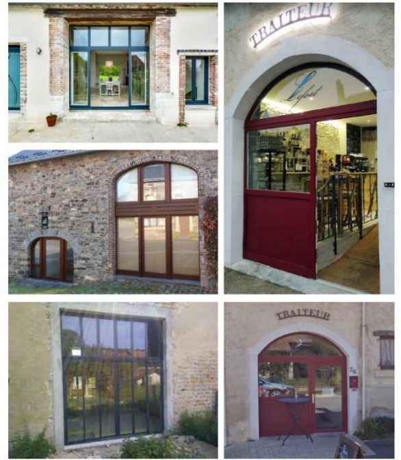
Images de référence de portes de grange vitrées (PVC, bois ou alu)
